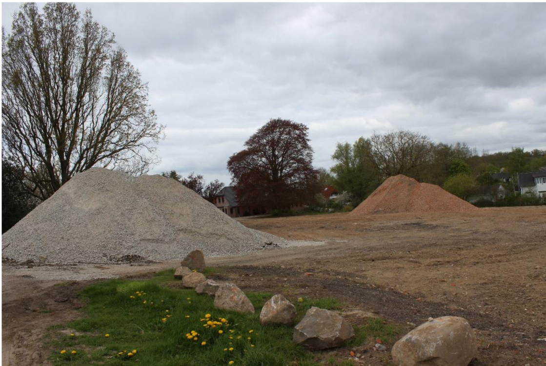
Anfang Mai 2023 ist es geschafft. Nur noch zwei Bauschuttberge erinnern an die nervtötend geräuschvollen Arbeiten auf dem Gelände.
