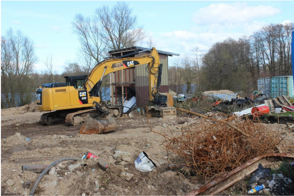
Anfang April 2023 war noch schweres Gerät im Einsatz, um die Baustelle zu räumen.
